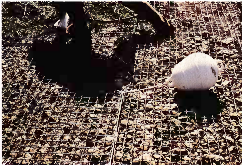
Photo 3. Montage des frayères artificielles : assemblage de l'armature.
