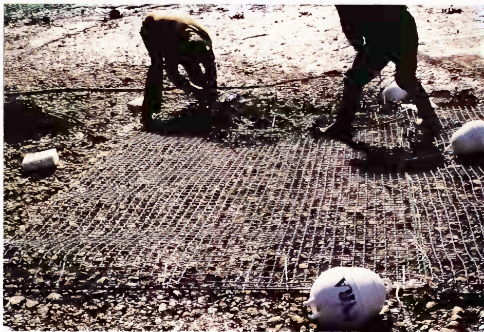
Photo 4. Montage des frayères artificielles : fixation des branchages sur le grillage de l'armature.
