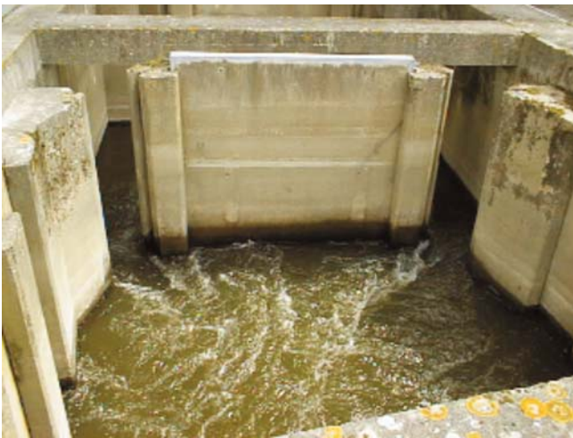
Photo 3. – Passe à bassins de Belleville, vue d'un bassin.
