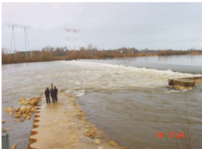
Photo 8. – Saint-Laurent : Entrée de la passe à l'aval.
