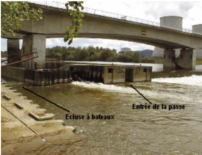
Photo 2. – Passe à bassins de Belleville (RD) vue de l'aval.
