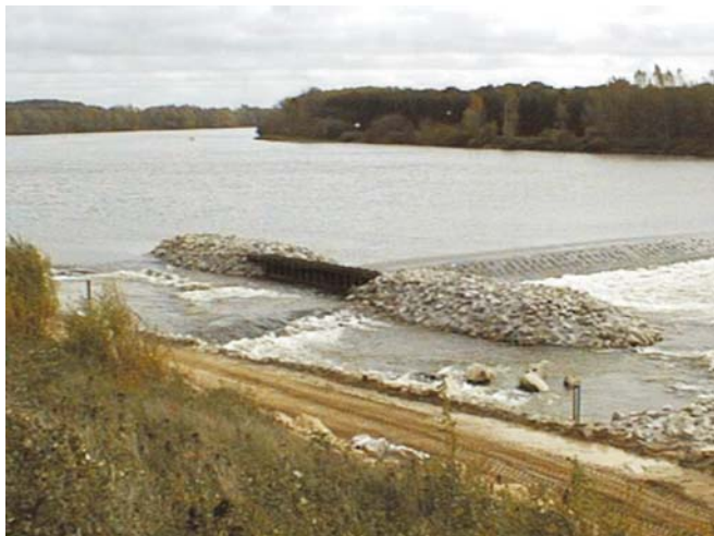
Photo 5. – Passe en enrochements, Dampierre RG.
