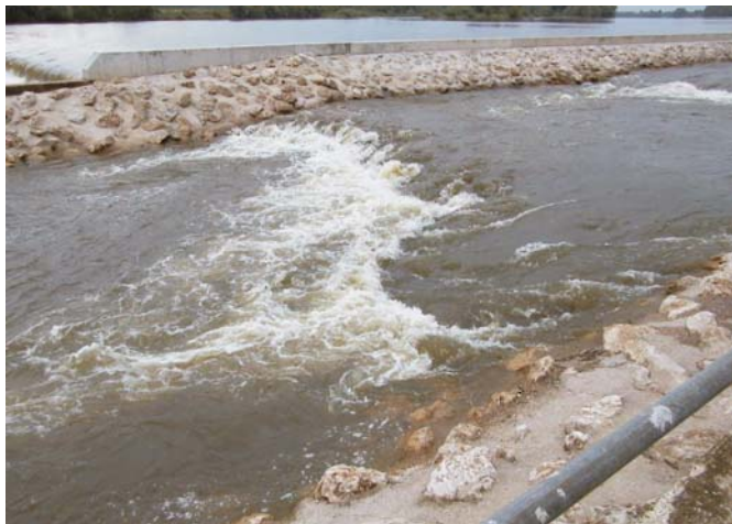
Photo 7. – Saint-Laurent : Ecoulement oblique sur un seuil ménageant une zone de passage privilégiée le long de la paroi.
