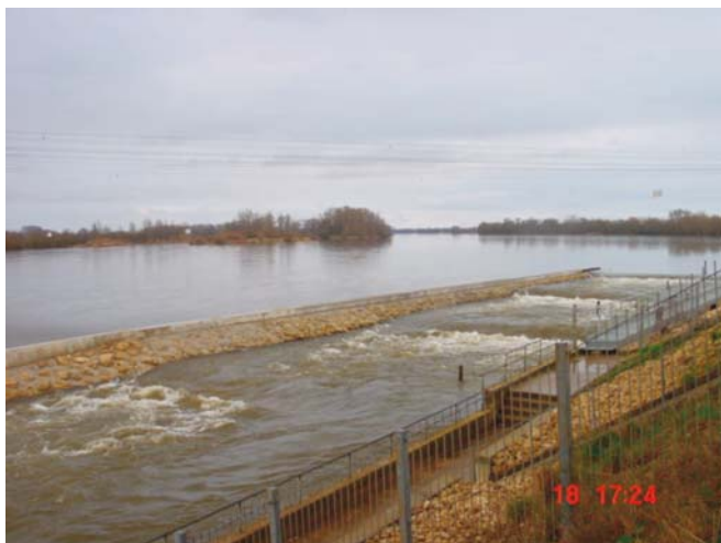
Photo 6. – Passe en enrochements, Saint-Laurent.
