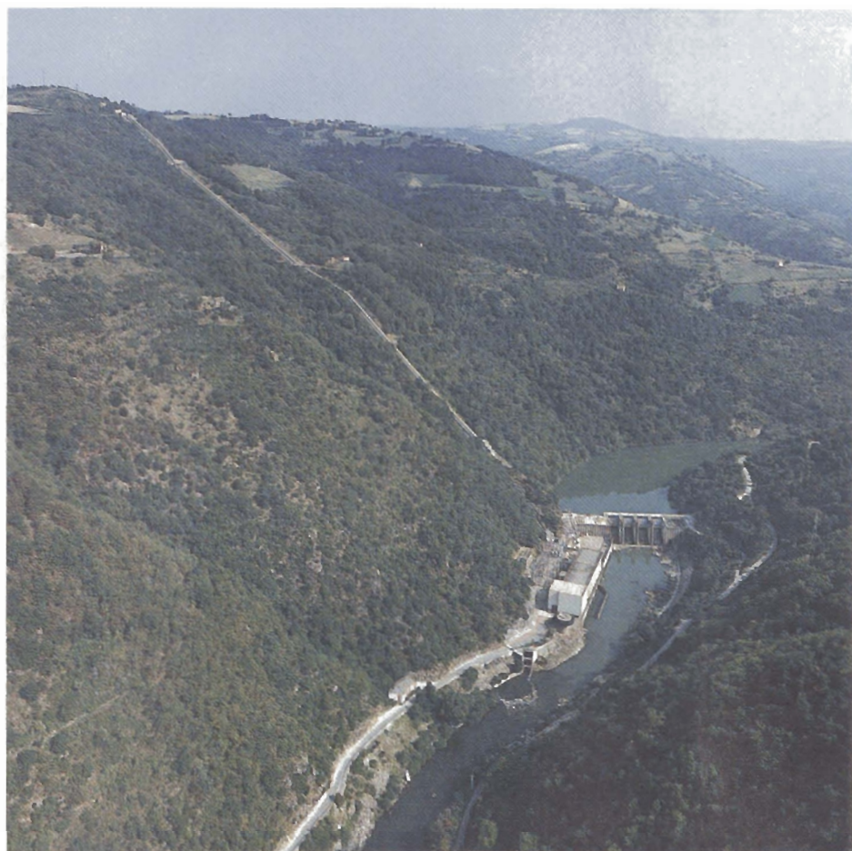
Fig. 4. – Vue de l'usine hydroélectrique du Pouget.
